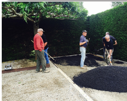
Etalement de l'enrobé à froid pour la finition.
