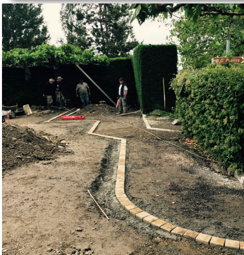
Pose des pavés sur les fondations en béton
