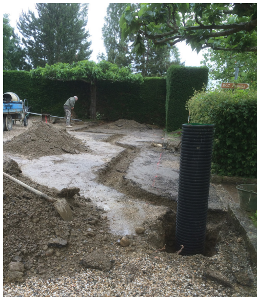
Création des tranchées et des évacuations des eaux de pluie
