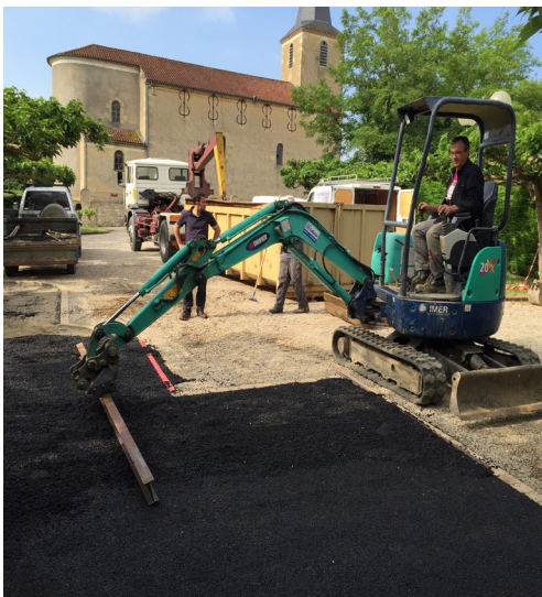
Etalement de l'enrobé avec la mini-pelle.
